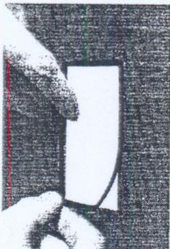
Oter la pellicule de protection du joint torique et le mettre en place autour de la découpe sur le côté extérieur du panneau.
