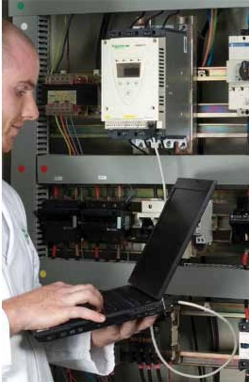
Messa in servizio dell'avviatore-rallentatore progressivo ATS 22 con il software di configurazione SoMove
